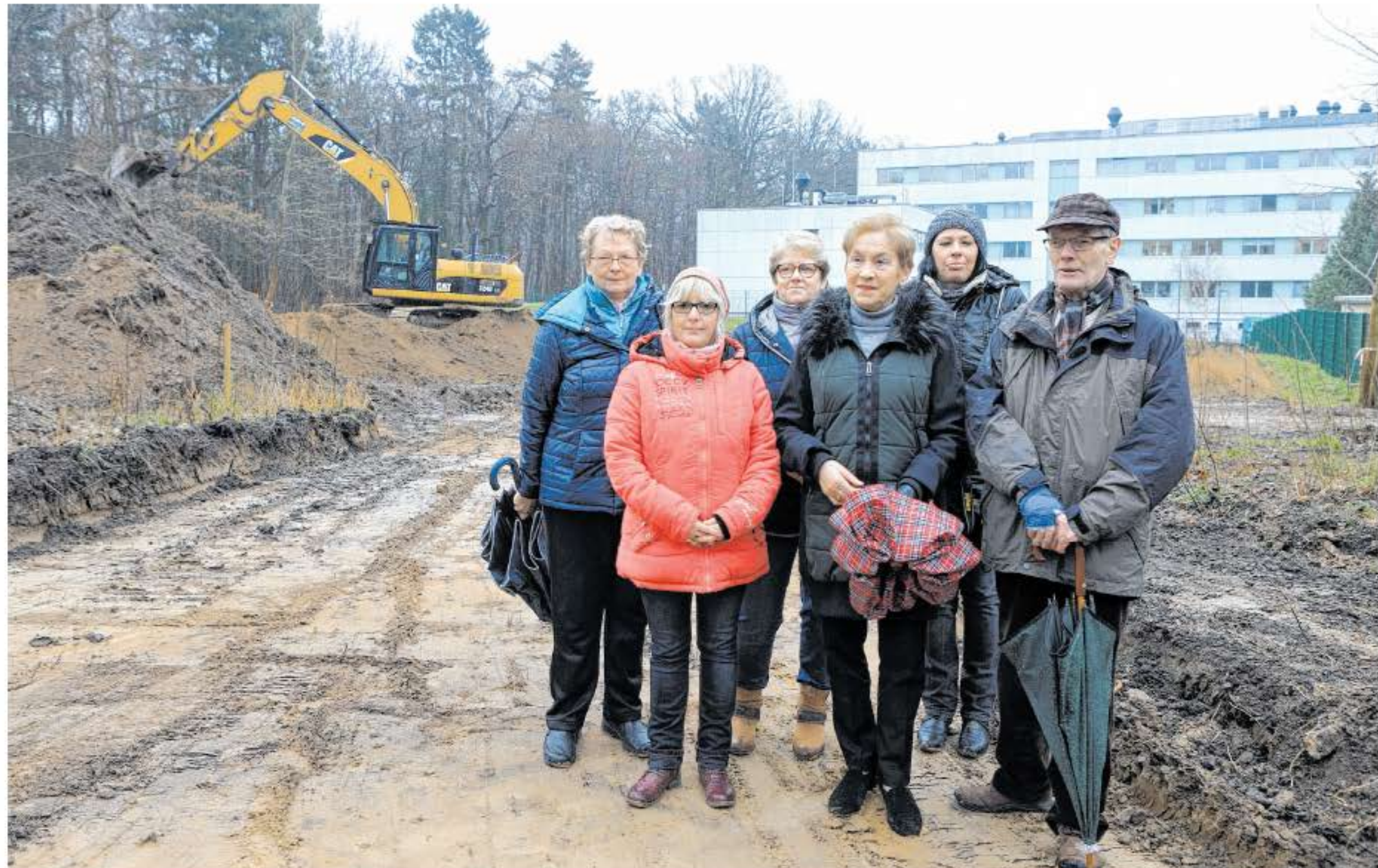
Adelheid Saretz, Marika Wolff, Brigitte Geist, Gudrun Eggers, Silke Strümper und Hans-Joachim Bartsch (v.l.) vom Kinderkrebshilfeverein freuen sich über den Baustart am Dr.-Lorenz-Weg. Wo sich jetzt Schlammberge türmen, soll im September das neue Eltern-Kind-Haus stehen. FOTO: OVE ARSCHOLL
